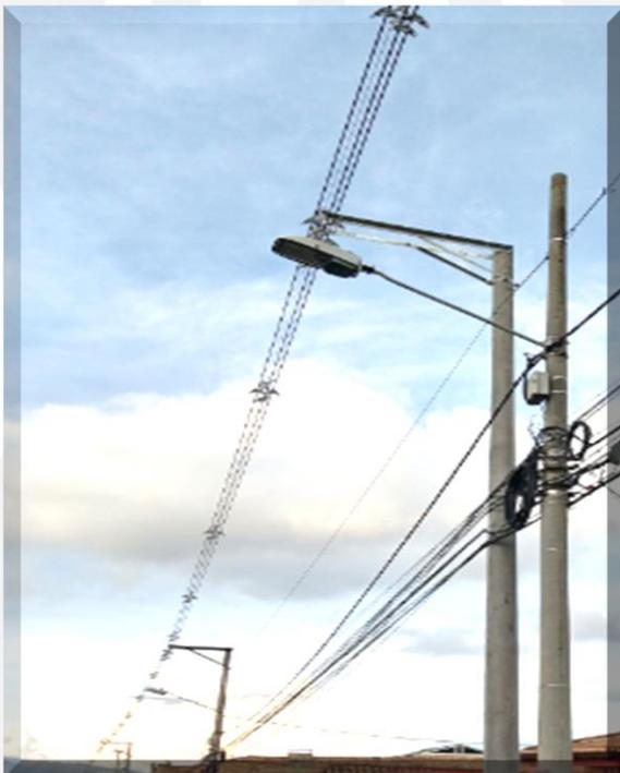
En este sentido, EBSA informa que se viene instalando **CABLES SEMI-ASILADOS o ECOLÓGICOS**, en zonas con alta presencia de arborización, donde la continuidad del servicio eléctrico se ve afectada por el contacto momentáneo o permanente de las ramas de los árboles y/o por animales (aves) con las líneas aéreas desnudas existentes. **Esta medida reduce o evita las interrupciones del servicio.**
